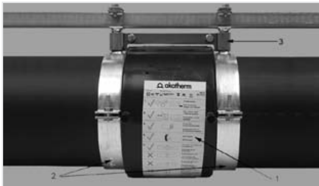
Figuur 12.45 Horizontaal vastpunt 200, 250 en 315 mm
